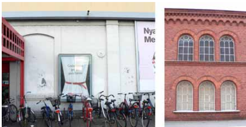
Figur 46-47. Under lagret av färg finns tegelfasader med utsmyckning i form av till exempel blindfönster och pilastrar. Ursprungliga gjutjärnsfönster finns bevarade på vissa fasader.
