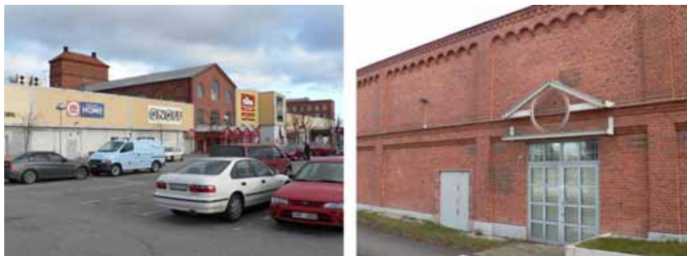
Figur 35-36. Norra byggnaden (Spinneriet) södra och västra fasaden.
