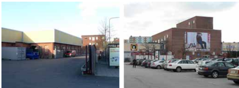
Figur 43-44. Södra byggnaden (Väveriet). Östra och norra fasaden
