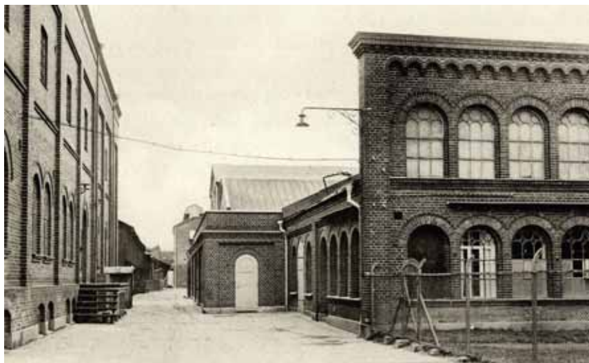
Figur 26. Vy mot väster, omkring 1930. Till höger i bild ligger spinneriet. Vi ser dess östra fasad med de rundbågiga fönstren. Till vänster ligger garnlagret som idag är rivet.
