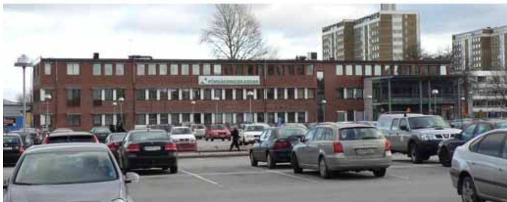
Figur 45. Kontorsbyggnaden, västra fasaden.
