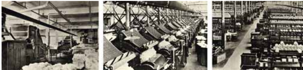
Figur 12-14. Bomullen packas upp. Kardmaskiner. Finspinningen.
