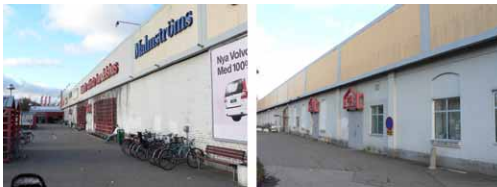
Figur 41-42. Södra byggnaden (Väveriet). Södra och västra fasaden.
