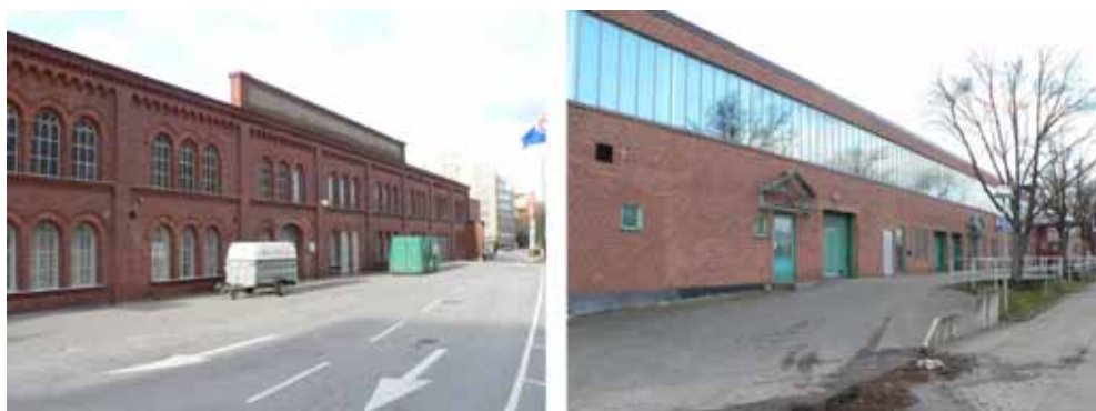
Figur 37-38. Norra byggnaden (Spinneriet) östra och norra fasaden.
