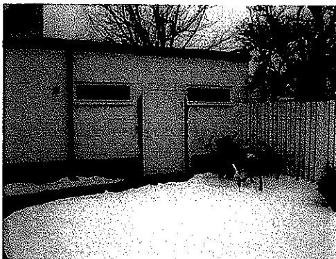
Gårdsbyggnadens östra fasad.
